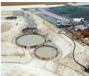
Projet Saron Biogaz
